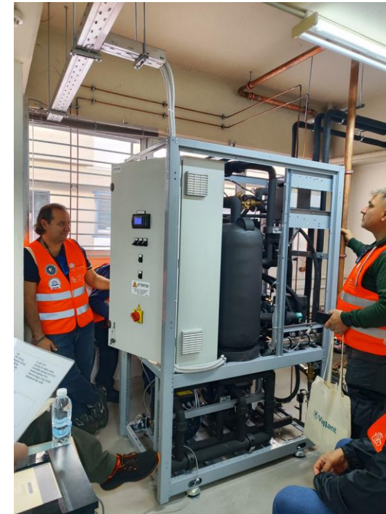
Ασκήσεις πεδίου σε μονάδα CO2 σε εγκαταστάσεις ψυκτικών θαλάμων του ΕΜΠ
